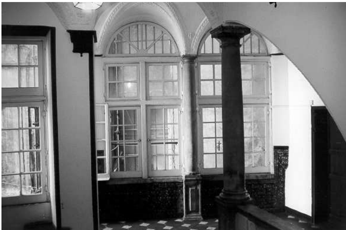
Fig. 3 - Palazzo Pinelli (piazza Pinelli, 2). Vano caposcala al piano nobile. Particolare del loggiato con le pareti parzialmente rivestite in azulejos .
