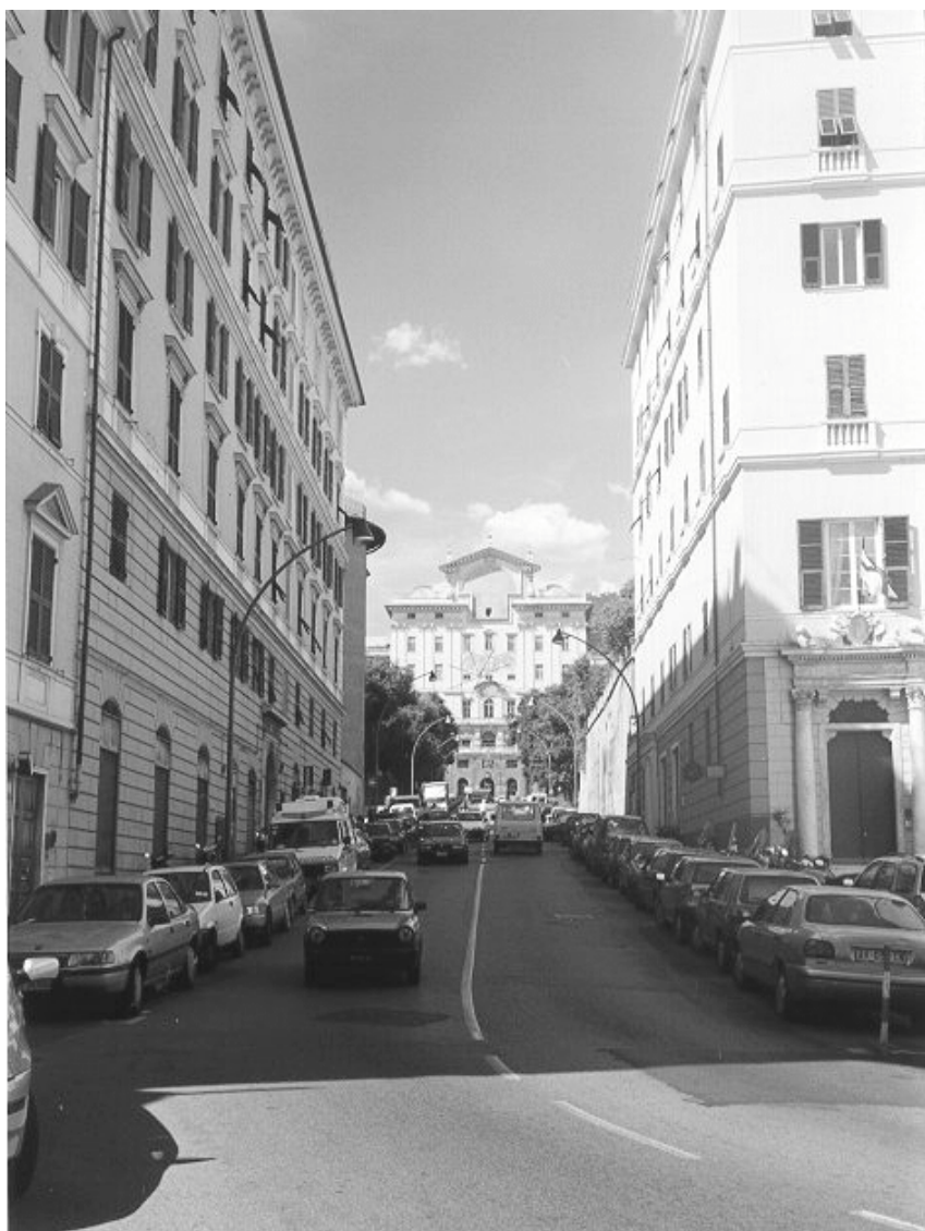
Fig. 5 - Albergo dei poveri, parte centrale della facciata meridionale vista dall'attuale Corso Emanuele Brignole.
